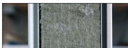
Isolation des parois en laine de roche
